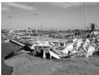
津波により倒壊した二高ヨット部 備品庫 ー閑上ヨットハーバー
